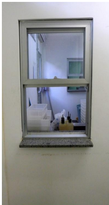
Figura 23 – Guichê de passagem na área de higienização, Biotério de Experimentação, Lacen B
