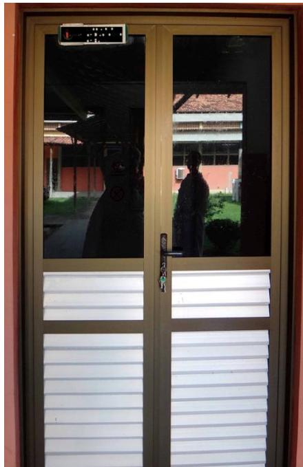
Figura 2 – Entrada principal, Laboratório de Diagnóstico de Raiva, Lacen A
