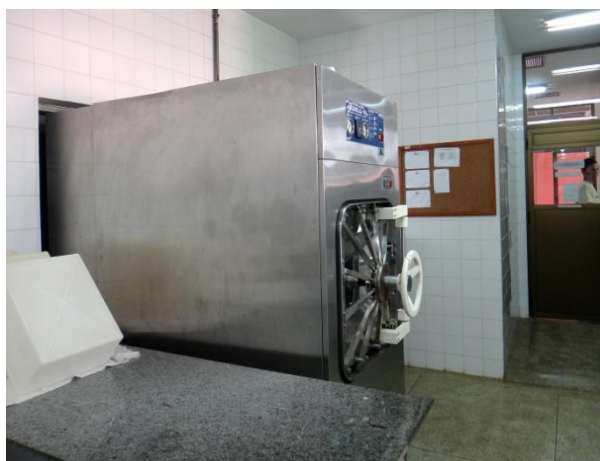
Figura 7 – Autoclave de dupla porta na área de higienização, Biotério de Criação, Lacen A
