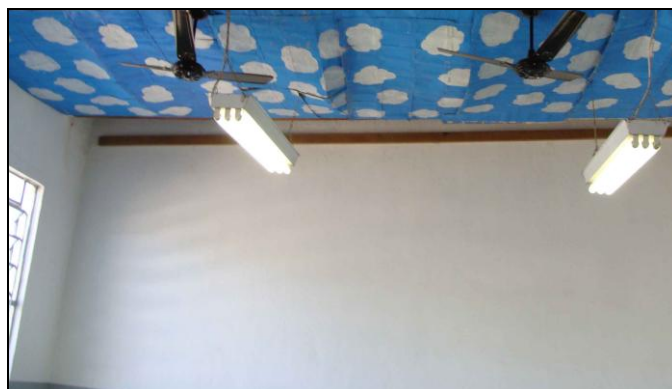
Sala de aula antes e após reforma e instalação do forro isolante térmica abaixo do telhado
