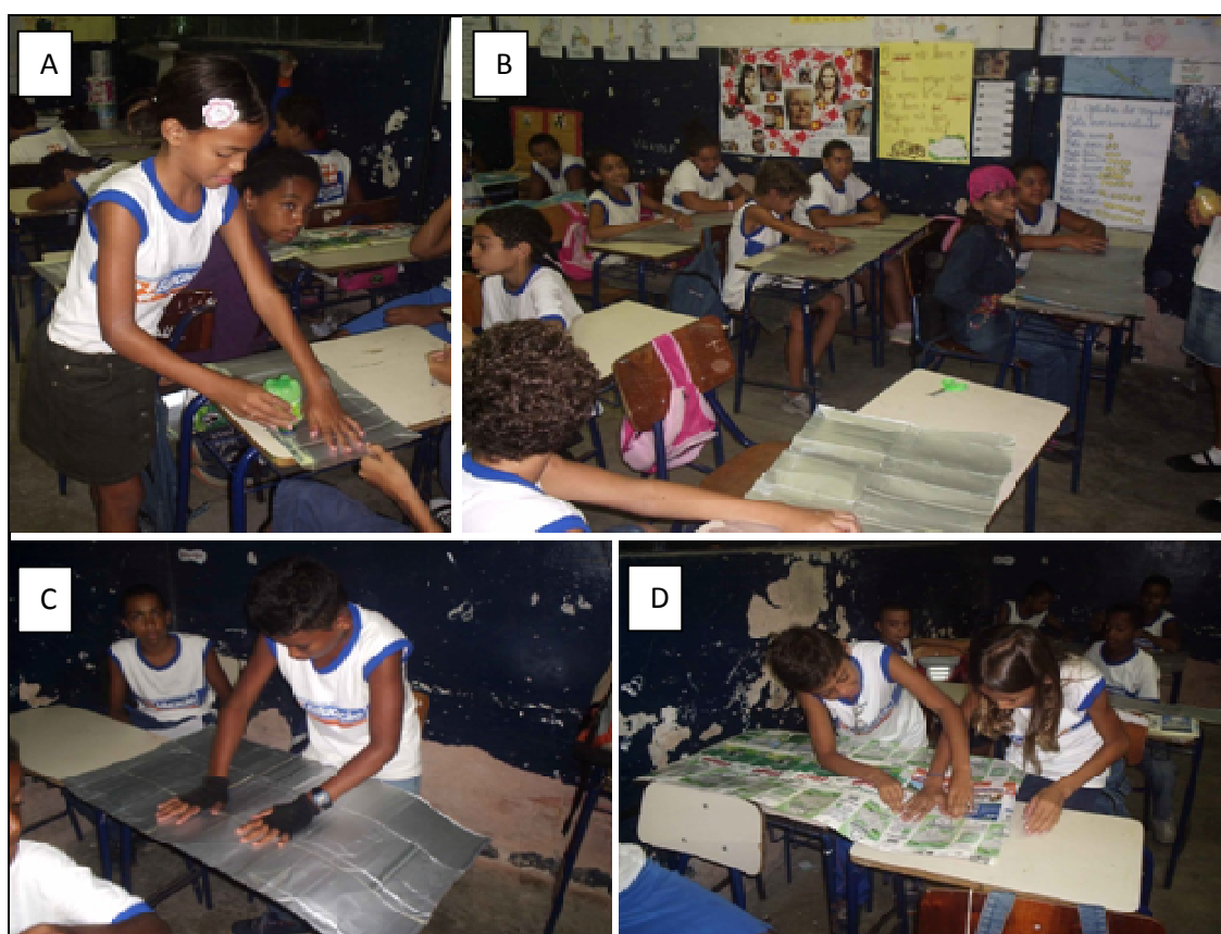
Figura 7: Oficina de colagem das embalagens cartonadas Longa Vida, com alunos do 6º ano, objetivando confeccionar mantas para subcobertura isolante térmica da sala de aula. A- aluna passa a cola, utilizando uma garrafa pet pequena, com um furo na tampa. B- os alunos aguardam o colega para mais uma rodada de passagem de cola nas mantas parcialmente construídas. C e D- alunos empenhados em fazer corretamente a colagem das embalagens Longa Vida.
