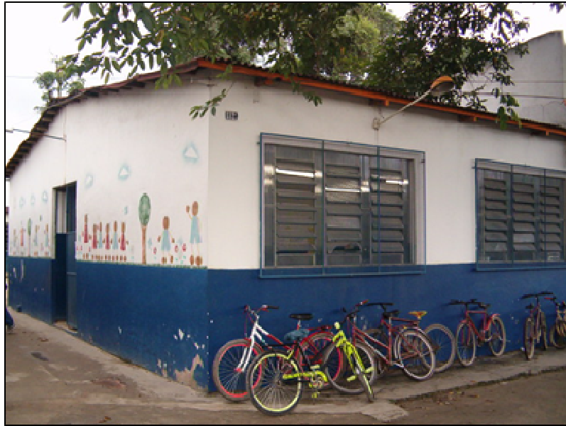
Figura 1: Escola Municipal Presidente Costa e Silva, no município de Duque de Caxias, na Baixada Fluminense. O prédio é coberto por telha asfáltica, sem qualquer tipo de subcobertura.
