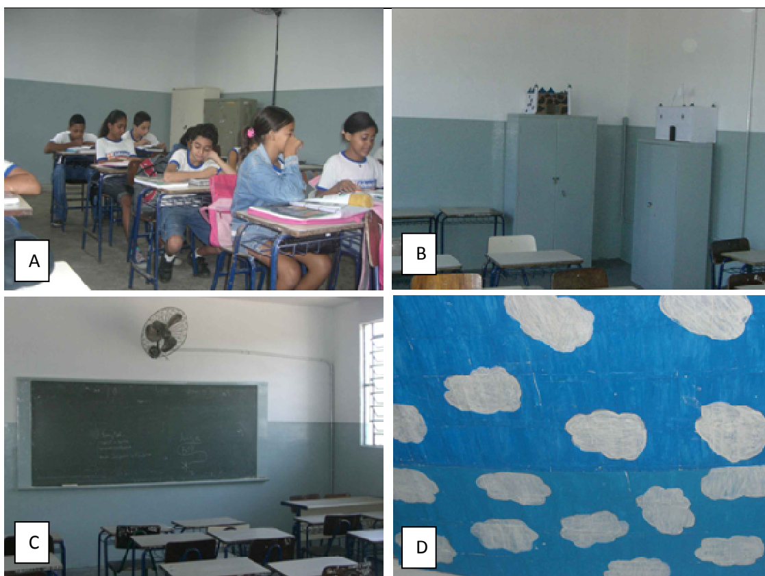
Figura 11: Sala de aula da Escola Municipal Presidente Costa e Silva, no município de Duque de Caxias, na Baixada Fluminense, após instalação da subcobertura isolante térmica (com pintura de motivo “céu e nuvens”) e após reforma realizada com recursos da Faperj. A- armários ainda não haviam sido pintados e o ventilador sem uso ainda estava na parede. B- mesmo canto da sala mostrado em A, agora com armários pintados e em nova disposição. C- vista do quadro de giz, já com a sala reformada, mas ainda com o antigo ventilador, que foi retirado posteriormente. O mobiliário permaneceu o mesmo devido à falta de recursos financeiros para a substituição. D- teto da sala, já com a subcobertura isolante térmica, que tornou o ambiente mais agradável, tanto do ponto de vista térmico, quanto estético.
