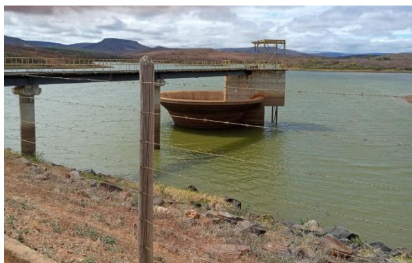
Figura 12 - Barragem do Calhauzinho.
