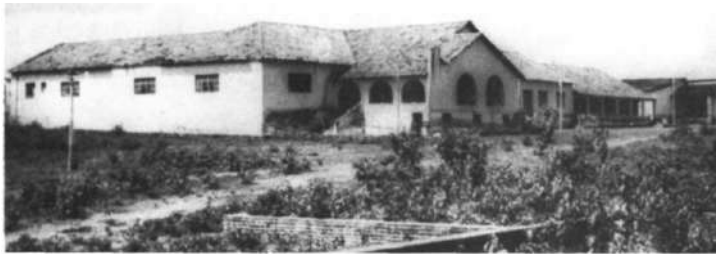
Prédio da Estação de Campo de Exu (1966)
