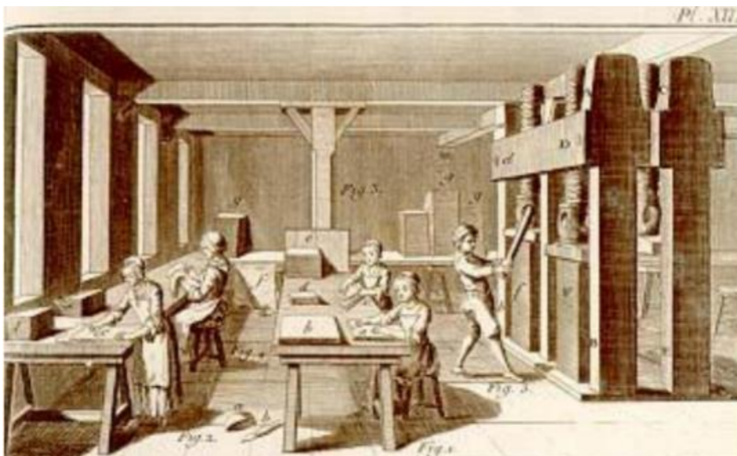
Fig. 42: Parte do processo de produção do papel. Mulheres e um aprendiz trabalhando na área de secagem do papel. Fonte: MET MUSEUM LIBRARY 157
