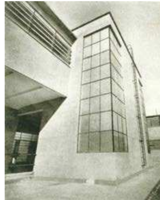
05 Caixa de escada na parte posterior do edifício.
