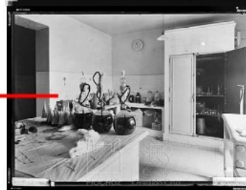
Obs: Sala com capela* Sala de preparo e meio de cultura - Sala 05
