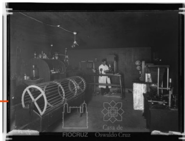
Sala de Macrofotografia e microfotografia – Copa e Sala de equipamentos Norte
