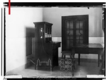
Central Telefônica/ Central de Termômetros elétricos/ Relógio elétrico - Sala H07
