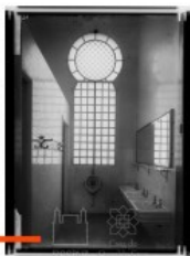
Lavatório e sanitários
