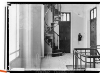
Circulação de acesso aos dormitórios
