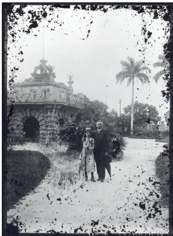
Figura 41: Visitantes diante da “monumental caixa d’água” inaugurada em 1901. Sob os arcos existiam gaiolas para corujas. Do outro lado da construção havia um lago para vitóriaas régias e uma escada que dava acesso ao mirante. Fotógrafo não identificado, ca. 1901. Coleção Fotográfica / Arquivo Guilherme de La Penha / MPEG.
