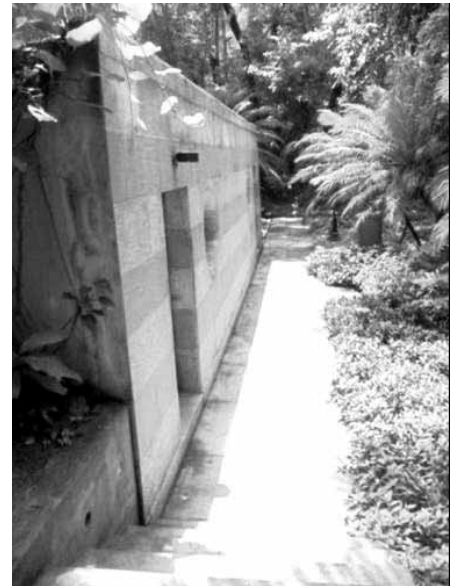
Figura 16. Prédio anexo à Cavaleriça construído na década de 1990. Foto: Ibam, 2010.
