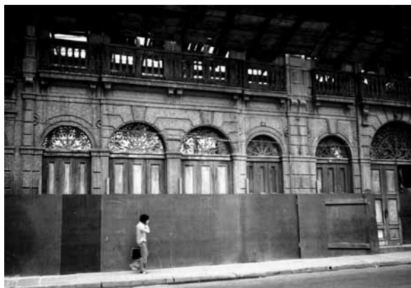
Figura 4. Fachada em cantaria R. São Bento Fonte: acervo SRBM
