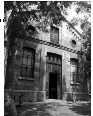
Figura 06. Cavalariça, construído em 1904 e tombado pelo IPHAN em 1981. Foto: Ibam, 2010.
