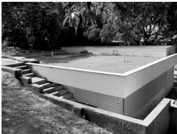
Figura 17. Edificação que abriga o Serviço de Tecnologias da Informação/COC, construída em 2010. Foto: Ibam, 2010.
