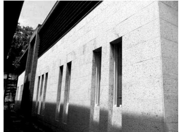
Figura 15. Prédio anexo ao Pavilhão do Relógio construído na década de 2000. Foto: Ibam, 2010.
