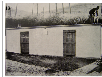
Figura 10: Autoclaves para expurgo da sacaria pelo sulfureto de carbono, em Santos.
