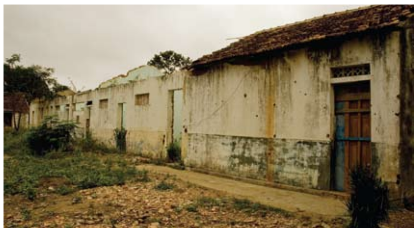
Escola abandonada no assentamento Zumbi 4
