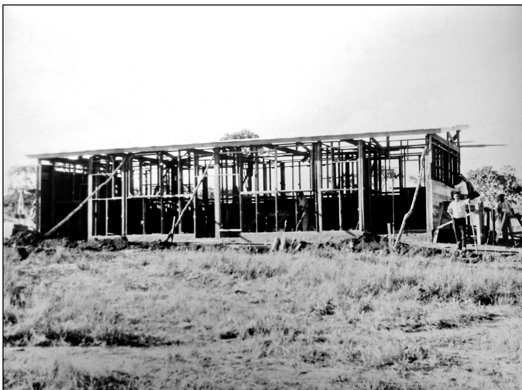
Início das obras do Hospital do IAPI - Hospital Juscelino Kubitschek de Oliveira (HJKO), janeiro de 1957*.
