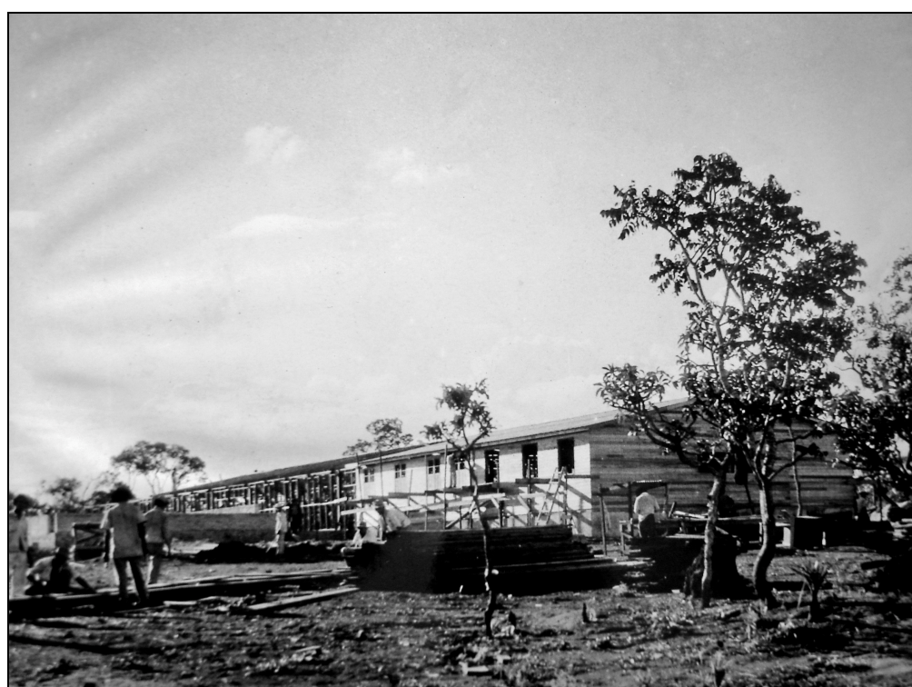
Construção do hospital HJKO, em abril de 1957*.
