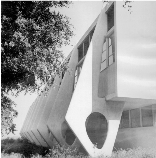
Figura 44: Conclução das obras do Pavilhão Henrique Aragão. Fonte: DAD/Fiocruz.
