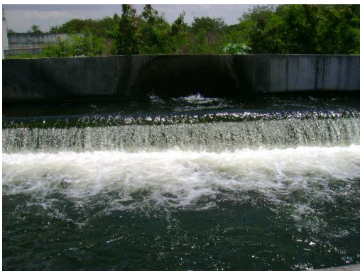
Figura 10.1.3.6. Efluente final tratado
