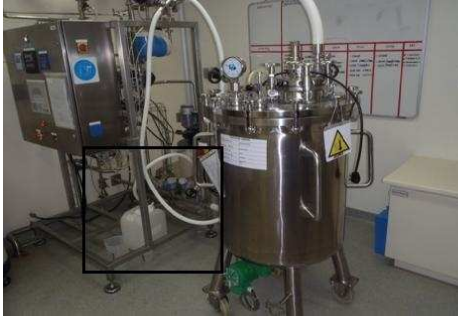
Figura 12: Ponto1 com tanque acoplado à CIP/SIP em operação de lavagem automática.
