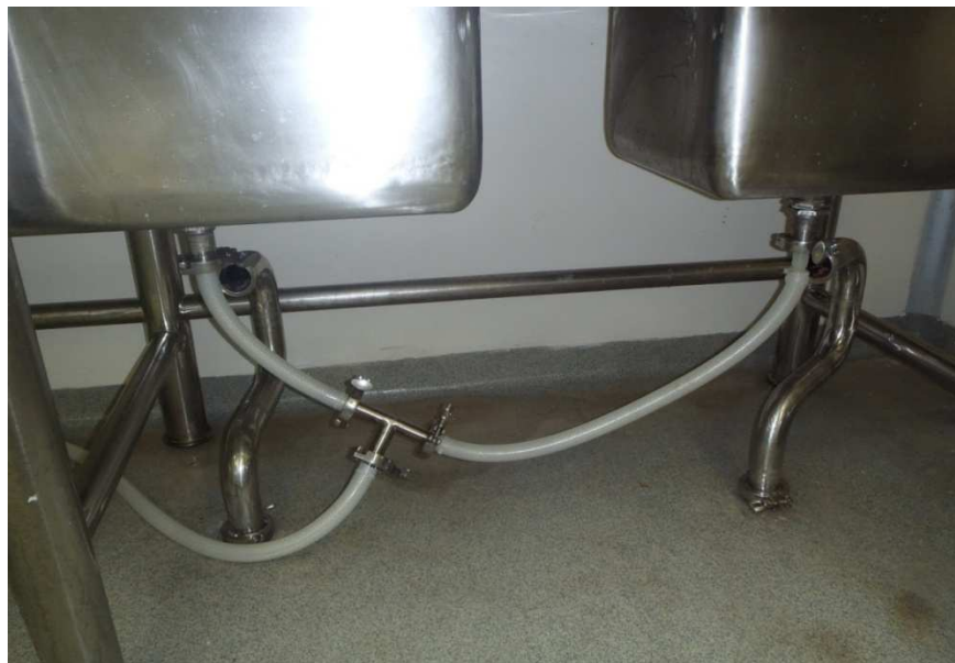
Figura 15: Ponto 2 – Adaptação para coleta de amostra antes de confluir com outros efluentes.
