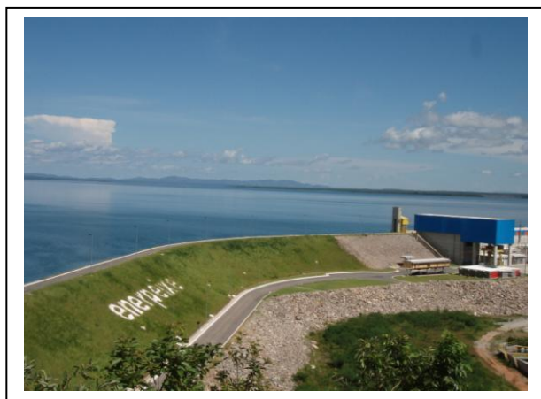
Fig. 1.2- Rio Tocantins, Usina Hidrelétrica de Peixe Angical.
