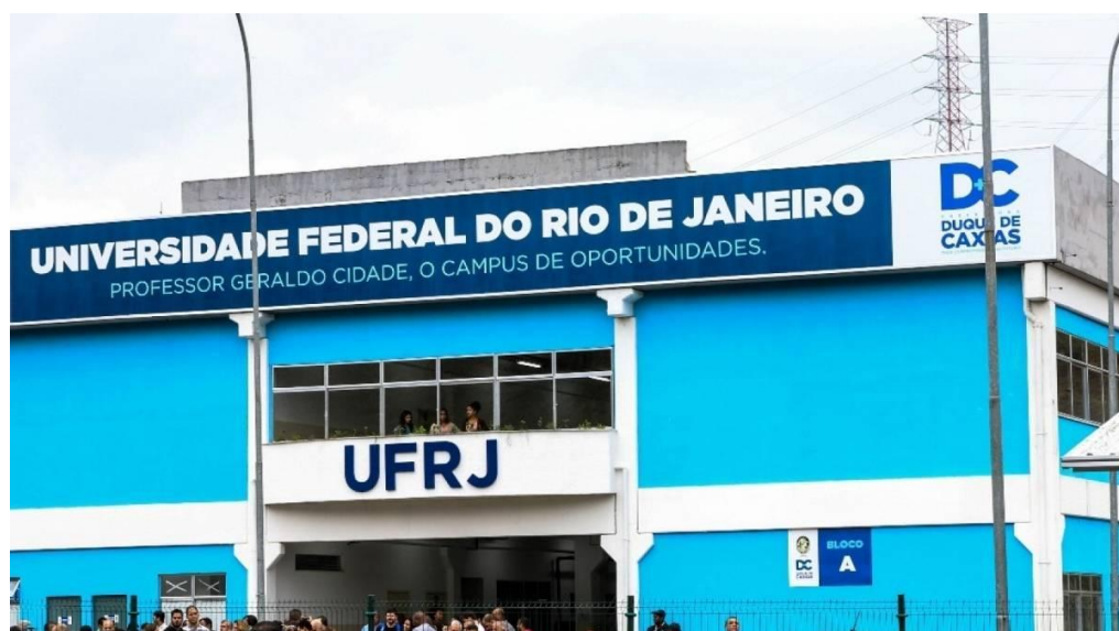
Imagem 4 - Faculdade de Educação da Baixada Fluminense (FEBF). Imagem 5 – Universidade Federal do Rio de Janeiro, unidade Xerém. Fonte: Site da FEBF e da UFRJ Xerém
