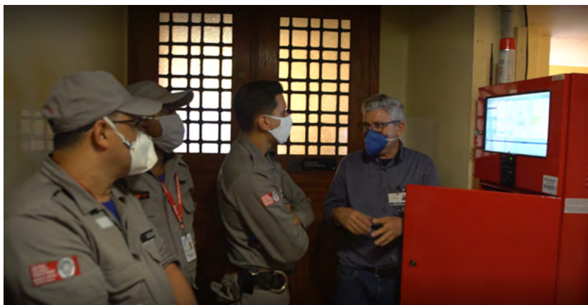
FIGURA 31 | Treinamento da Brigada de contingência para operação do novo sistema de detecção e combate a incêndio do Pavilhão Mourisco.
