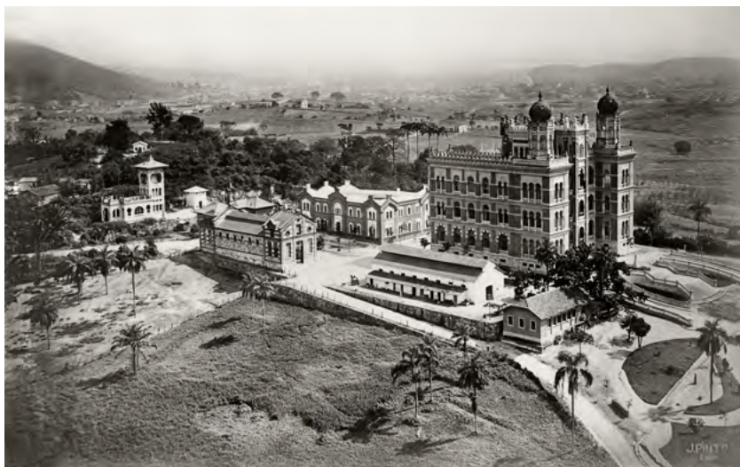
FIGURA 6 | Vista do conjunto arquitetônico construído para abrigar as atividades da instituição no início do século 20, com destaque para o Pavilhão Mourisco. FOTO: J. PINTO. FONTE: ACERVO DAD/COC/FIOCRUZ.
