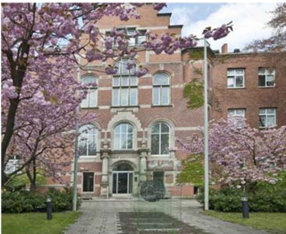
Figura 3.24: Entrada do edifício principal em Berlim, Wedding.
