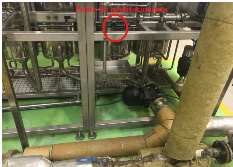
Figura 30: Ponto de monitoramento de recebimento de PW.
