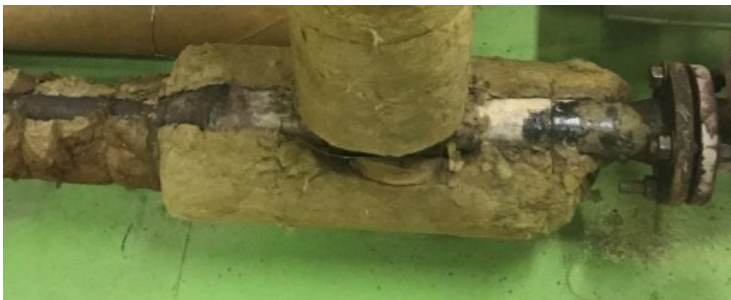
Figura 25: Rede de distribuição de WFI.
