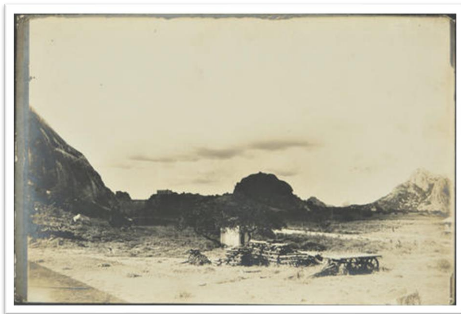
Imagem 4.2 – Barragem do açude e casa da Inspetoria de Obras contra as secas
