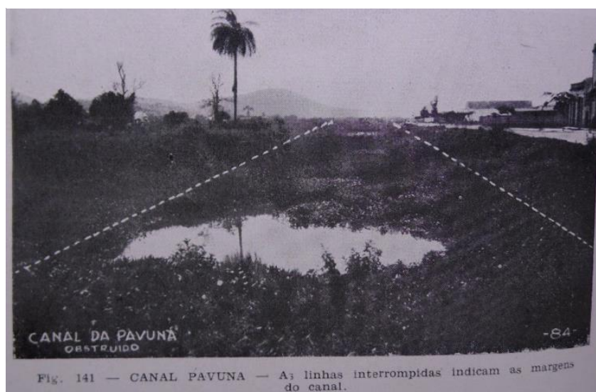
Figura 22: Canal da Pavuna obstruído em 1933.
