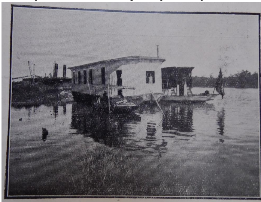
Figura 12: Casa Flutuante que abrigava os engenheiros.
