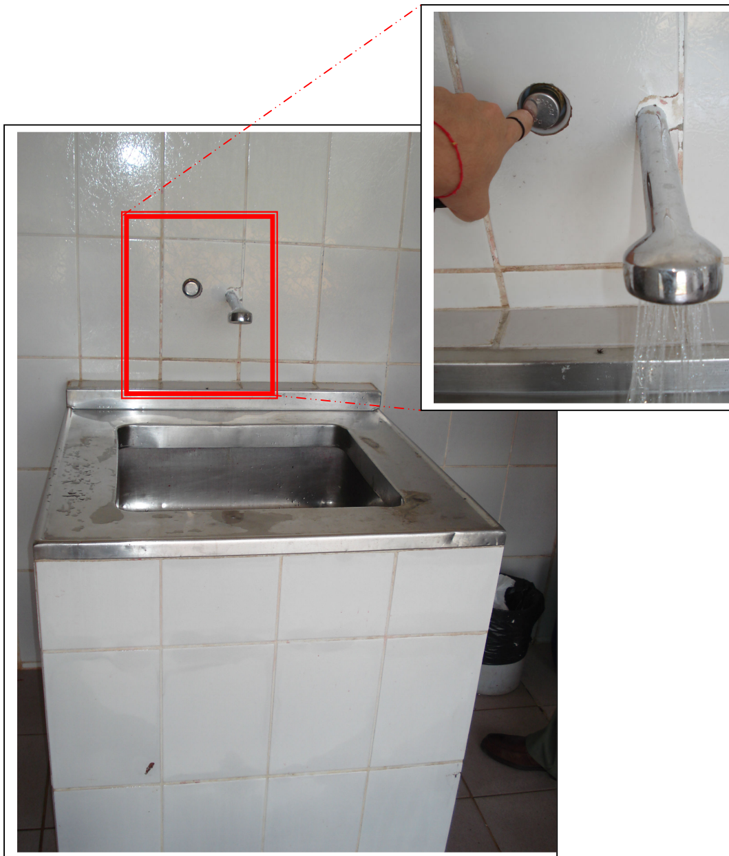
Figura 08 – Foto ilustrativa do ponto de oferta de água para higienização das mãos dos trabalhadores da área da cloaca e de controle da entrada de resíduos sólidos provenientes do parque aeroportuário.
