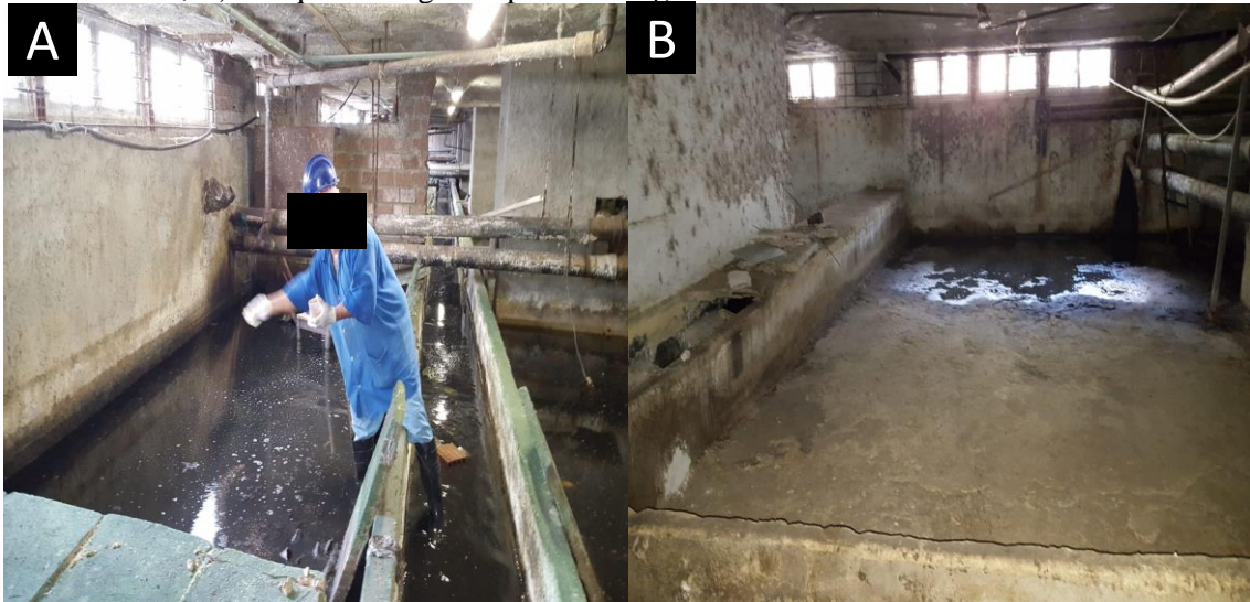
Figura 8 Tanques localizados no subsolo do Hospital das Clínicas. A) Tanque com água, sendo tratado com larvicida; B) Tanque sem água - após a drenagem.
