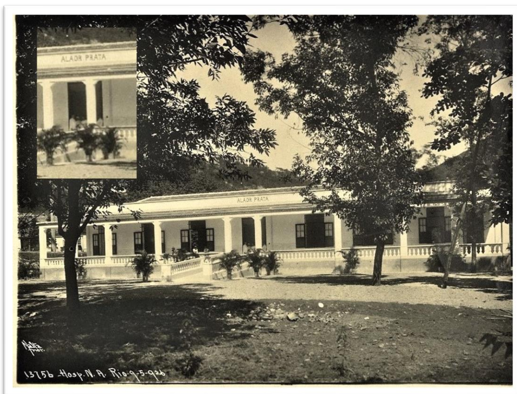
Figura 30 - Pavilhão Alaor Prata – frente
