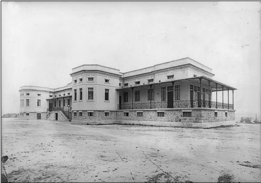
Fig.10 Prédio do Hospital Oswaldo Cruz recém concluído em dezembro de 1918. Fonte: DADCOC
