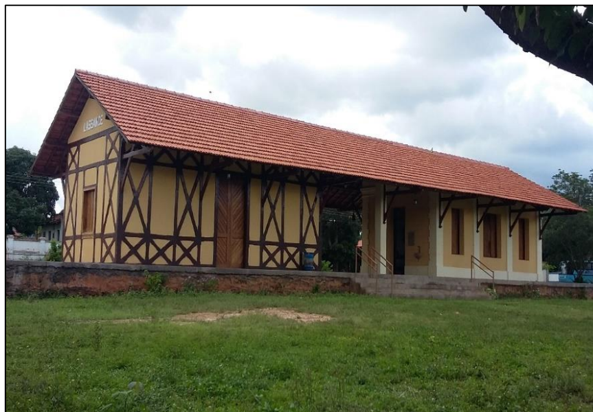
Fig.11 Estação Ferroviária de Lassance Fonte: Trabalho de campo, Lassance, 2017.
