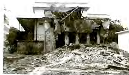
Demolição do Necrotério próximo ao então Pavilhão Gaspar Vianna (atual Hospital Evandro Chagas), como parte do programa de recuperação de Manguinhos. (DAD/Fiocruz)
