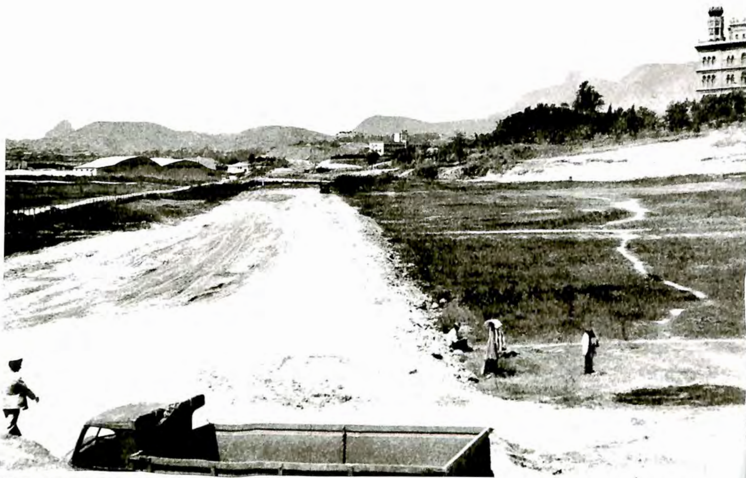
Imagens da abertura da variante da Rio-Petrópolis (atual Avenida Brasil) no terreno do Instituto Oswaldo Cruz. A foto à direita foi tirada do terraço do quinto pavimento do Pavilhão Mourisco. (Revista Municipal de Engenharia, março de 1941. Biblioteca Noronha Santos, Iphan)
