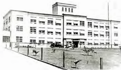
Fachada principal do edifício da Fundação Rockefeller construído em terreno do Instituto Oswaldo Cruz entre 1935 e 1937. Esta imagem mostra o edifício sem a cobertura de telhas cerâmicas.
