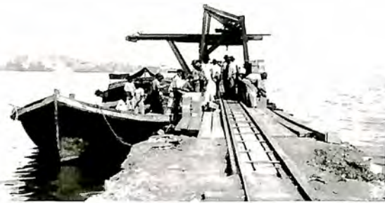
Cais original. O acesso de parte dos funcionários e do material para a construção do Pavilhão Mourisco era feito por ele. (DAD/Fiocruz)
