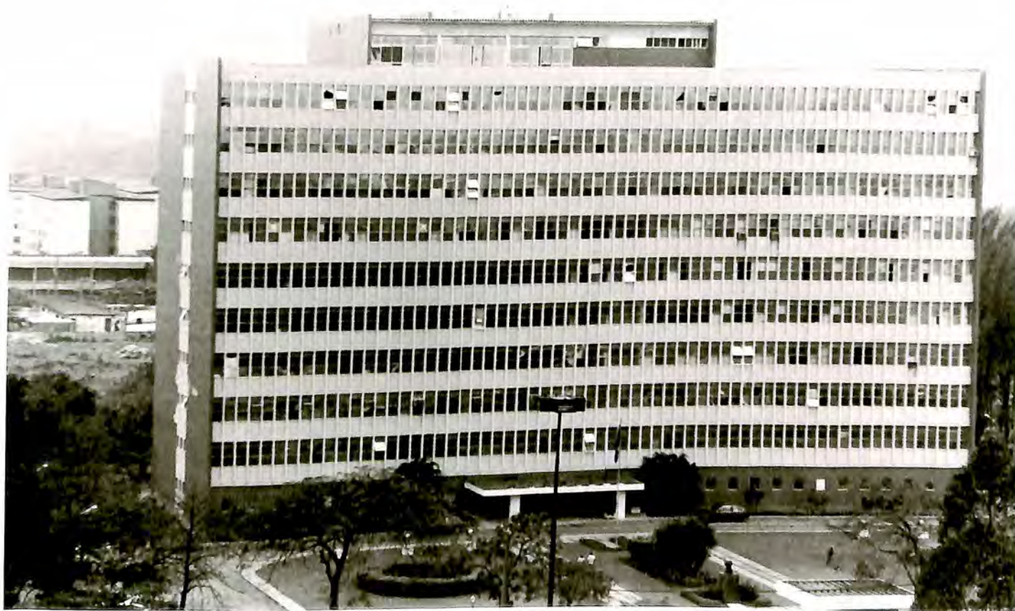
Inaugurado apenas em 1972, o atual edifício da expansão do campus foi projetado para funcionar inicialmente como um hospital; acabou sendo a sede do Ministério da Saúde no Rio de Janeiro. Projeto do arquiteto Florealdo Albano, da equipe da Divisão de Obras do Ministério da Saúde. Foi incorporado ao campus na década de 80. (DAD/Fiocruz)
