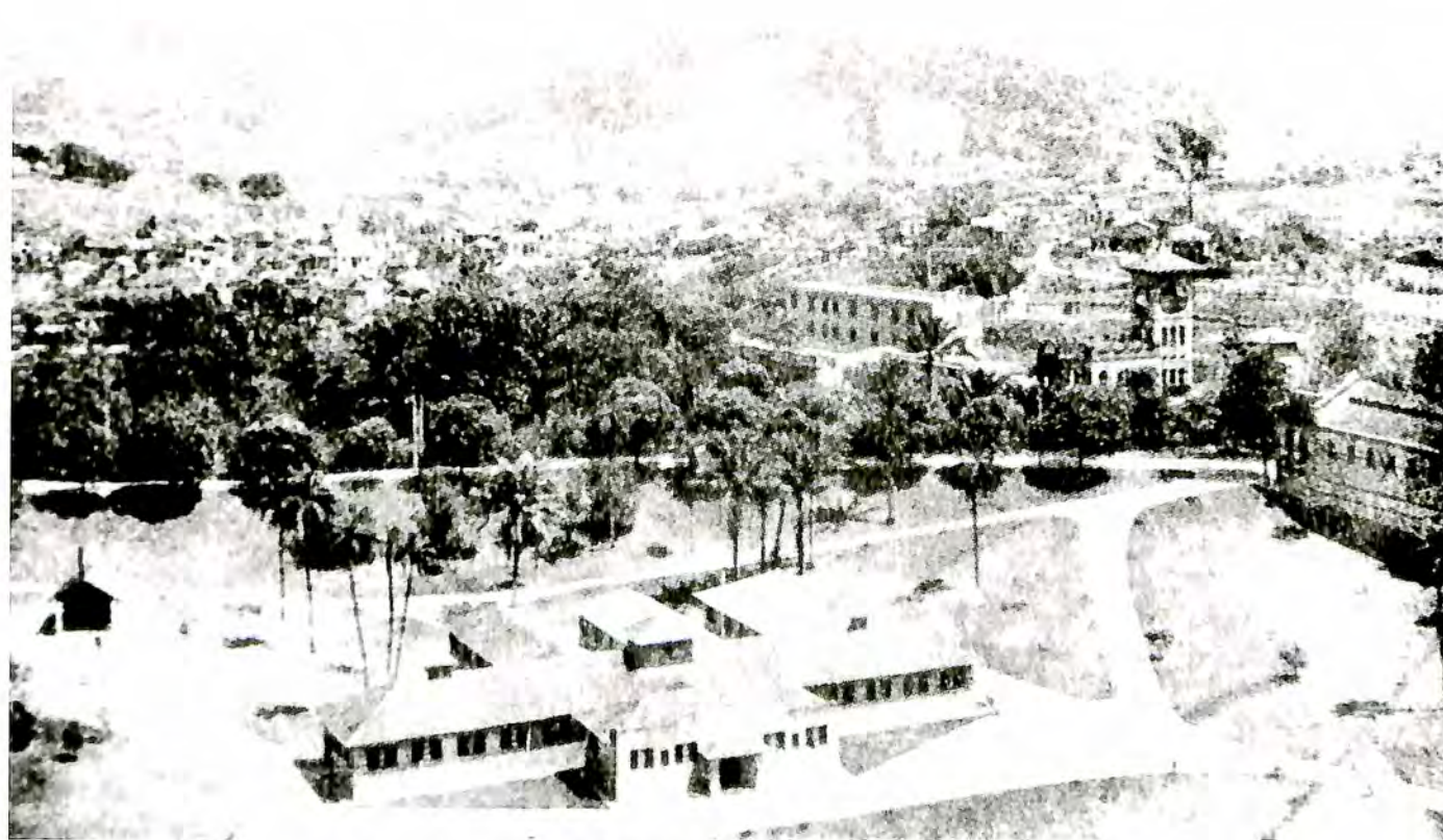
Vista externa do novo Biotério (atual Pavilhão Lauro Travassos), após os acréscimos de blocos contíguos. (Foto: Ribeiro, 1940)
