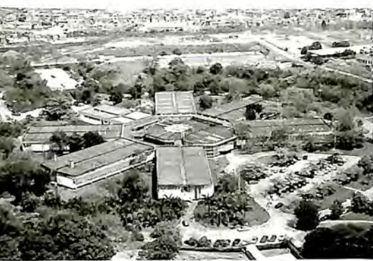
Edifício do Instituto Nacional de Controle e Qualidade em Saúde – INCQS – marca a retomada de construções de vulto na Fiocruz; projeto dos arquitetos Ary Celso France e Salomão Tandeta da Icoplan. (CCS/Fiocruz)
