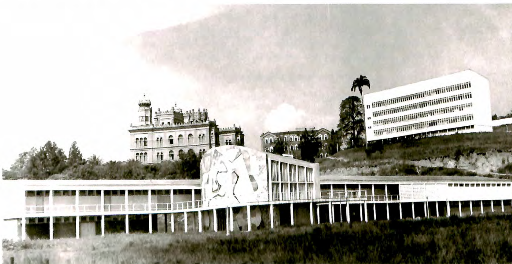
Conjunto de edificações modernistas construídas durante a gestão de Henrique Aragão, utilizando a linguagem da nova arquitetura como uma afirmação de sua gestão consolidadora. Em primeiro plano o Pavilhão de Cursos e à direita o Pavilhão da Patologia (atual Carlos Chagas). Ao fundo à esquerda o Pavilhão Mourisco e à direita o Quinino. (DAD/Fiocruz)
