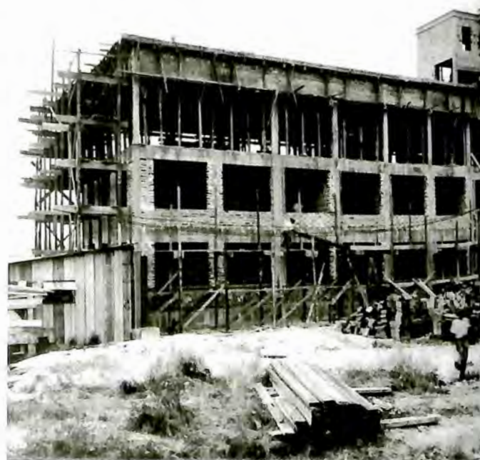
Aspecto das obras de construção do edifício da Fundação Rockefeller, de 1 de março de 1937. (Foto: Rembrandt. Rockefeller Archive Center)
