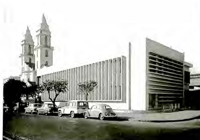
Vista externa do Centro de Pesquisas René Rachou (CPqRR), na esquina da Avenida Augusto de Lima com a Rua Juiz de Fora, em Belo Horizonte/MG. (DAD/Fiocruz)
