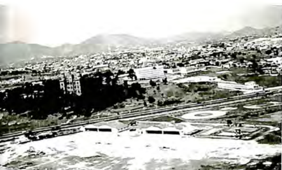
A Avenida Brasil, recém-inaugurada, limita definitivamente a área do campus de Mangueiras, cortando sua comunicação com o mar. Ao mesmo tempo possibilita novos acessos ao Instituto. Já se nota o grande contraste das construções de estilo modernista com o conjunto arquitetônico histórico. (DAD/Fiocruz)
