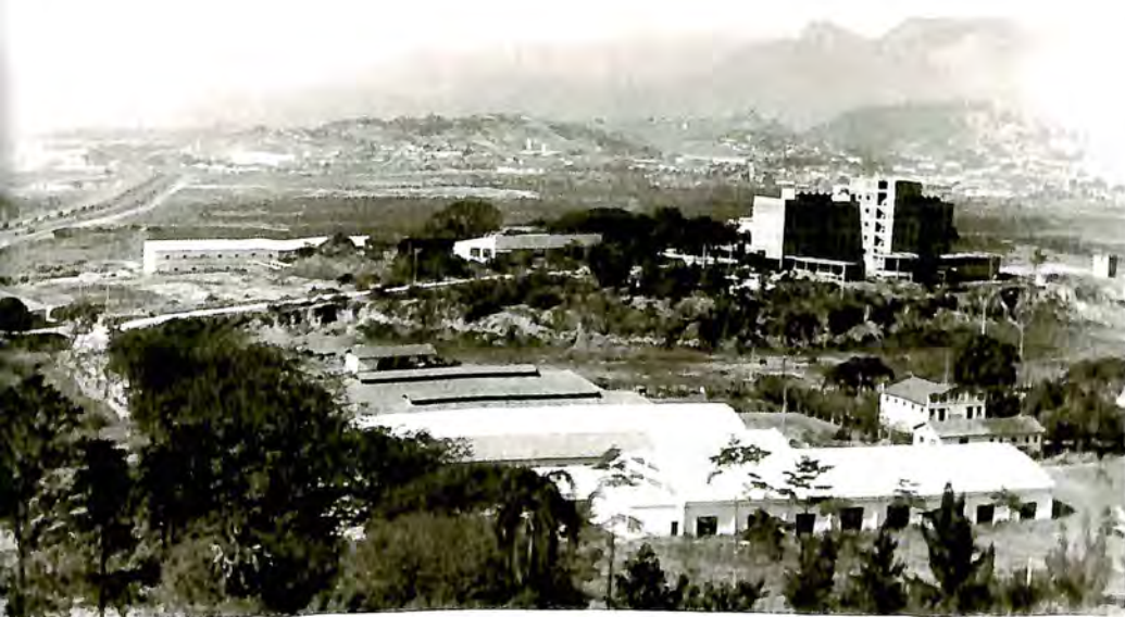
Oficinas e Garagem recém-concluídas e, ao fundo, o edifício destinado a substituir o antigo Hospital Oswaldo Cruz, em obras. (DAD/Fiocruz)
