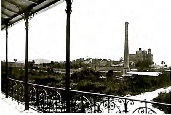
Vista do conjunto arquitetônico histórico de Manguinhos a partir da varanda do Hospital Evandro Chagas. Da esquerda para a direita: pombal, aquário (demolido), cavalaria, estrebaria (demolida) e Pavilhão Mourisco. Em primeiro plano as antigas instalações dos fornos incineradores de lixo com destaque para a chaminé. 1918. (MIS/Coleção Augusto Malta)
