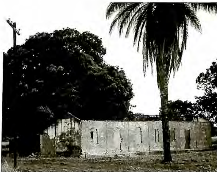
Antigo laboratório de Lassance, antes das obras de restauração (Iepha)
