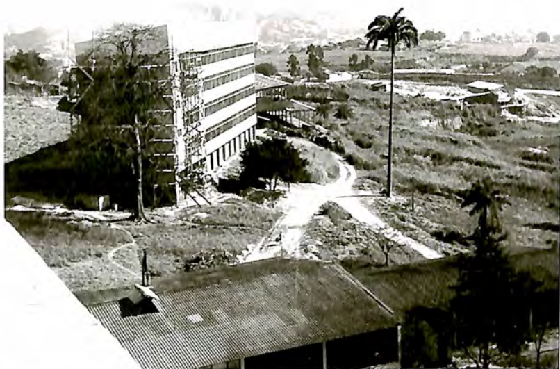
O Pavilhão da Patologia (atual Carlos Chagas), em construção. Em primeiro plano cobertura do antigo Almoarifado.(DAD/Fiocruz)
