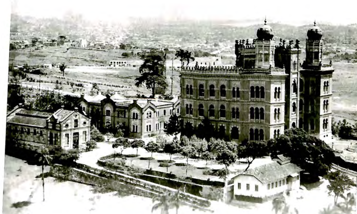
Conjunto arquitetônico histórico de Manguihos depois da demolição da estrebaria (s/d). (DAD/Fiocruz)
