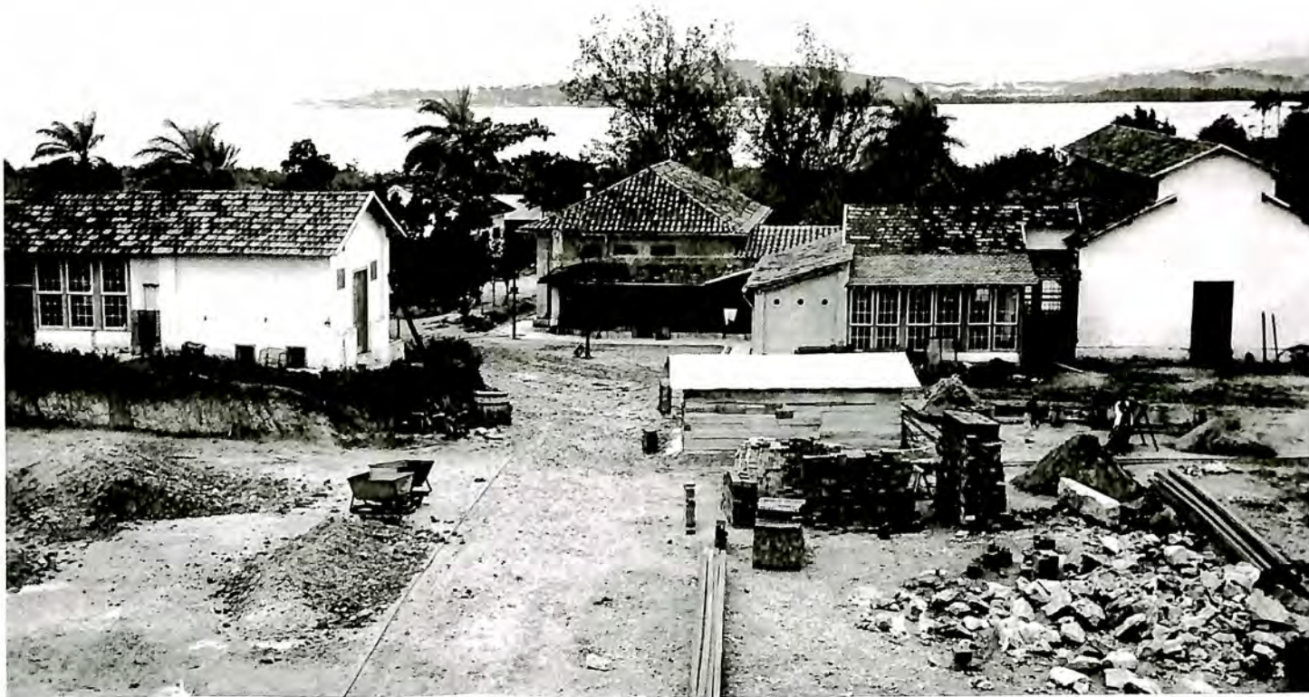
Início da construção da Cavalariça. A estrebaria, à direita, ocupou o lugar de uma edificação que comporia a futura Praça Pasteur, mas que não foi realizada. À esquerda o Instituto Soroterápico, funcionando ainda sob a administração de Pedro Affonso. (DAD/Fiocruz)
