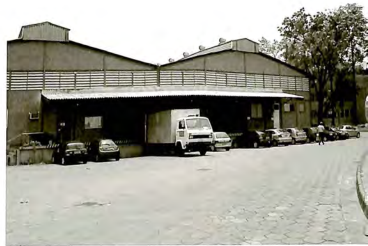
Almojarifado de Bio-Manguinhos. Projeto da Paal - Projetos Arquitetos Associados Ltda. (DPH/COC)
