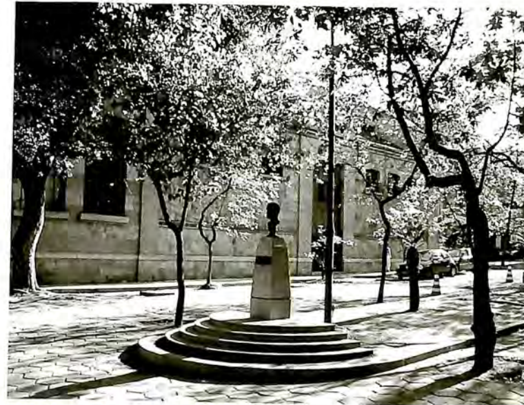
Praça Pasteur, após as obras de restauração. (DAD/COC)
