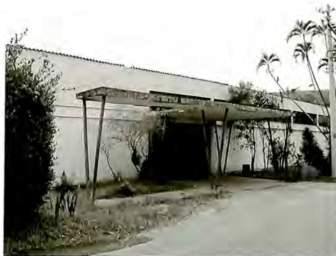
Entrada principal do Pavilhão Ministro Estácio Souto Maior, anexo agrícola do Manicômio Judiciário Heitor Carrilho, da Colônia Juliano Moreira. Inaugurado em 21 de junho de 1962 para o Serviço Nacional de Doenças Mentais do Ministério da Saúde. Projeto do arquiteto Ramiro Faustino Ferreira da Divisão de Obras. (Foto: Vinícius Pequeno)
