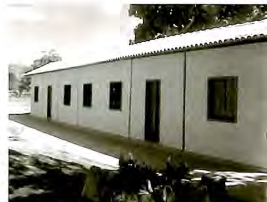
Antigo laboratório de Lassance, depois das obras de restauração (Iepha)
