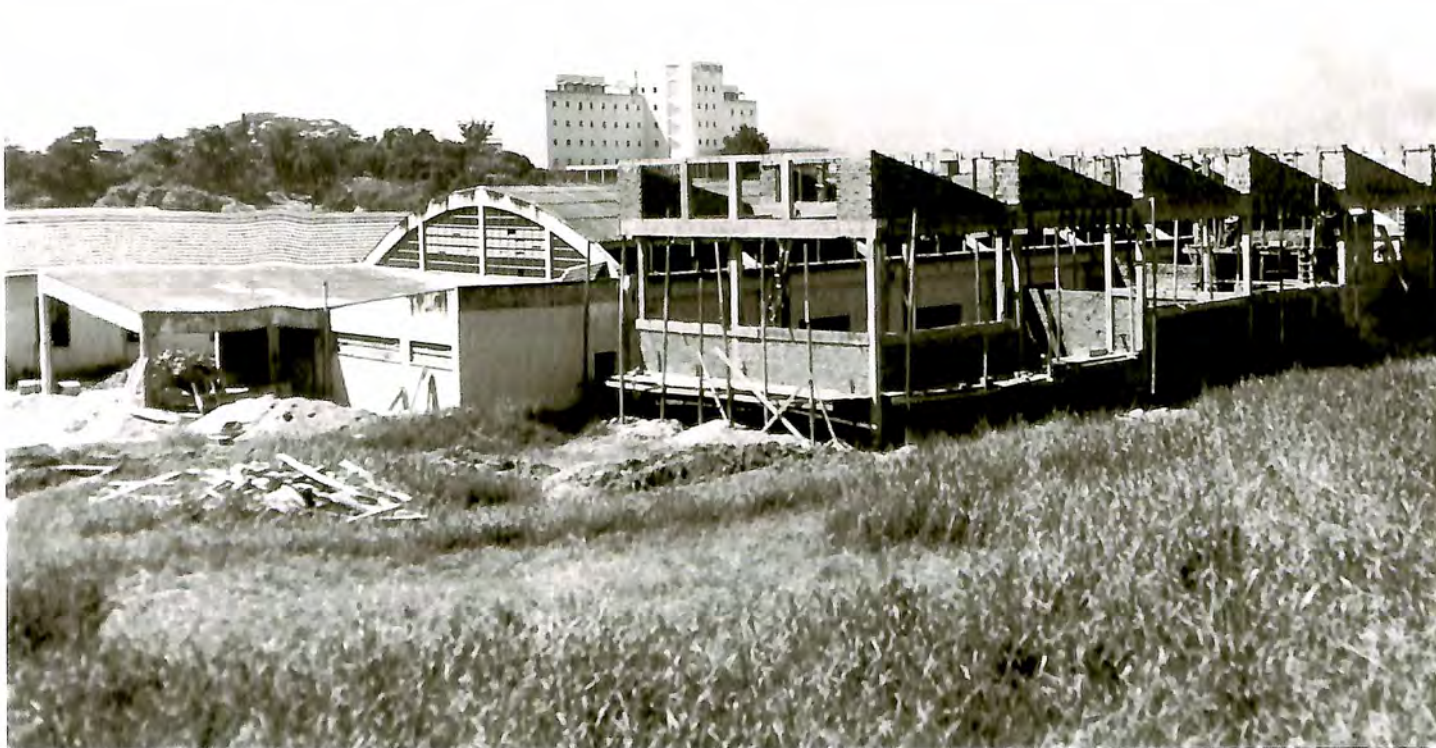
Ampliação projetada pelo arquiteto Waldyr Ramos da Divisão de Obras. (DAD/Fiocruz)
