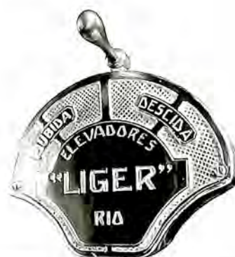
Detalhe da alavanca de controle do elevador do Pavilhão Mourisco. (DAD/Fiocruz)
