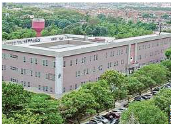
Prédio da escola: gasto total será de R$ 3,4 milhões B
