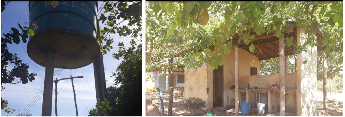
Figura 80 Fonte de abastecimento e armazenamento de água dos moradores da localidade periurbana Assentamento 17 de Abril em Teresina, estado do Piauí, 2017.
