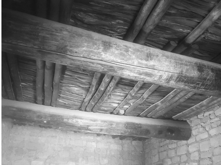
Figura 12 – Fotografia da cobertura original de um dos recintos de Aztec West Ruin . Foto: Karl Reinhard.
