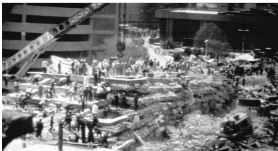
Figura 12 - Colapso total del hospital Benito Juárez, México, ocurrido pelo desastres 1985.
