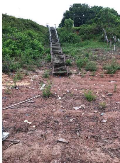
Figura 5 – Acesso à comunidade
