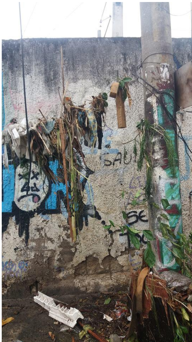
Foto 4 – Muro da Supervia. 15/02/2018. Acervo COMACS
