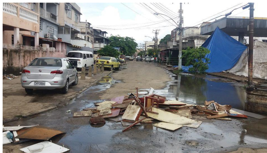
Foto 12 - Rua Humboldt, em Bonsucesso. 15/02/2018. Acervo COMACS
