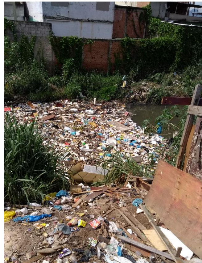
Foto 1 - Rio Jacaré na Rua Maravilha ao lado da adutora no CHP2. 15/02/2018. Acervo COMACS.
