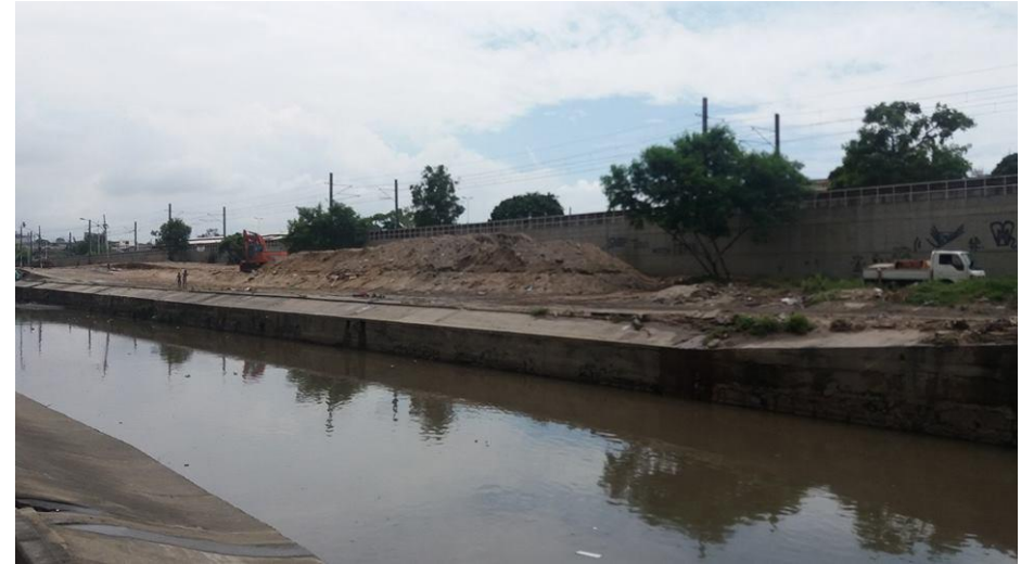
Foto 3 – Lodo e areia retirados na dragagem, e colocados na margem do rio. 15/02/2018. Acervo COMACS.
