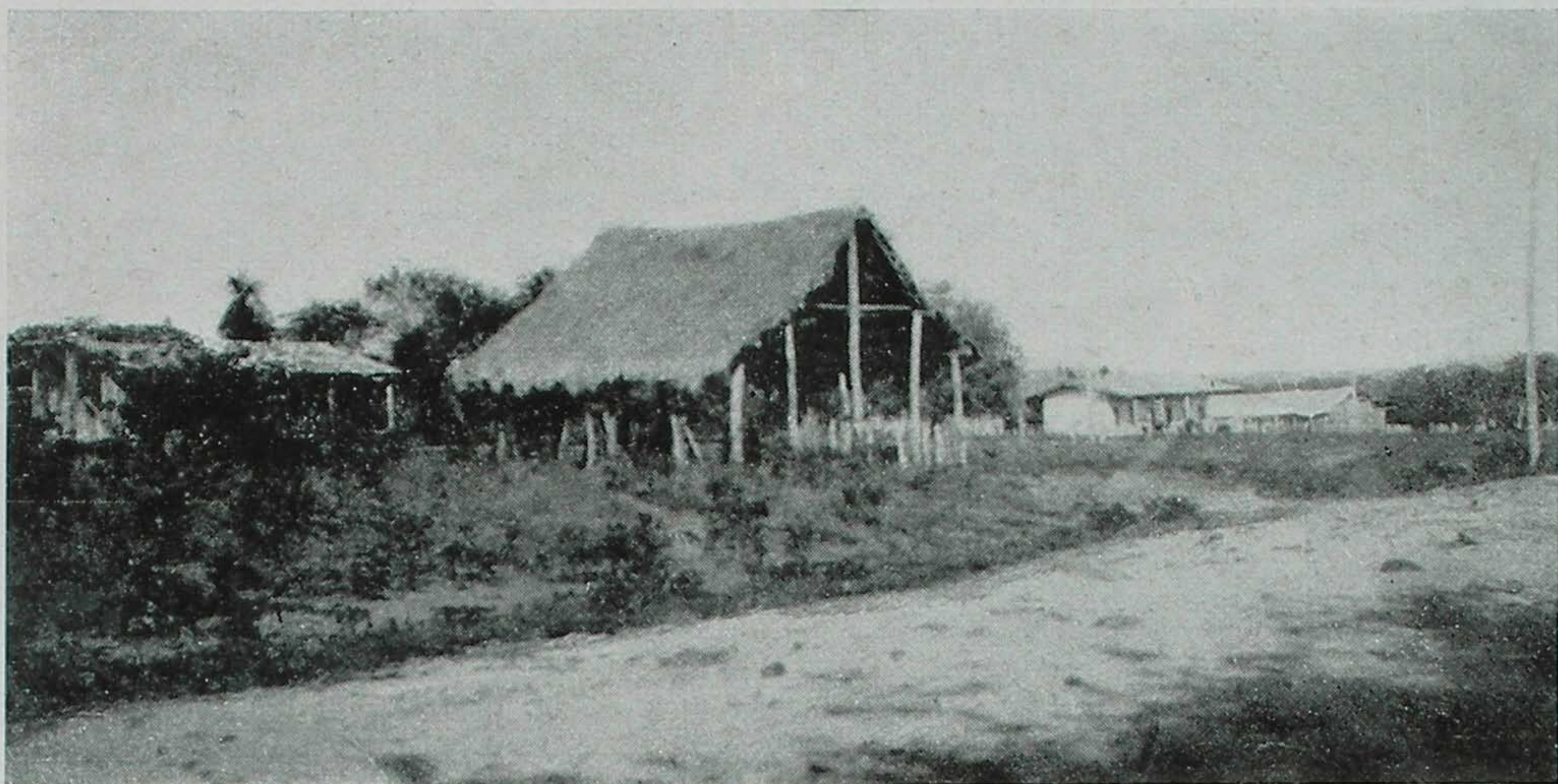
Fig. 59— Santa Ana —Alpendre que serve de pouso aos viajantes.
