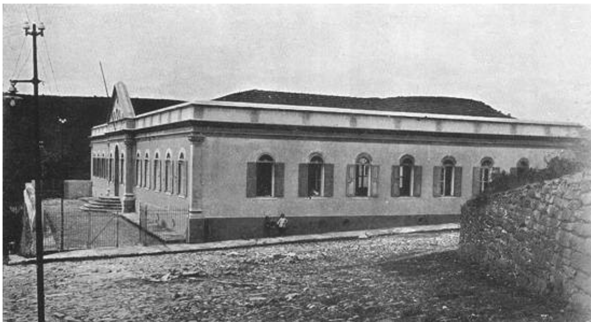
Figura 1 – Fachada da Escola de Farmácia no final do século XIX
