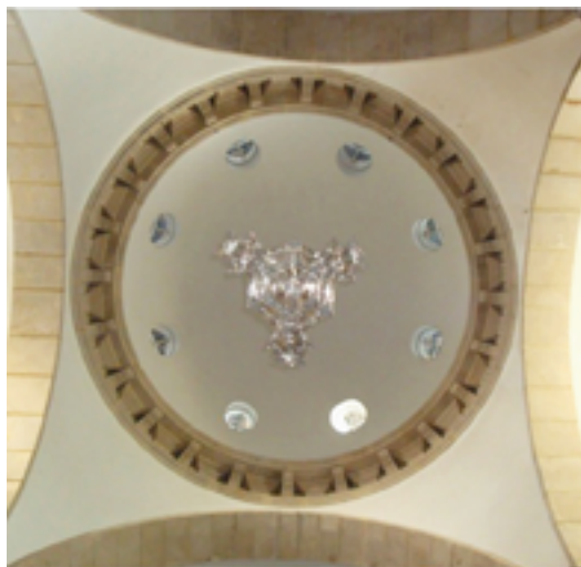
FIGURA 7 | Aspecto final da cúpula da Igreja de Santa Teresa após introdução dos novos fechamentos dos óculos com veneziana de vidro.
