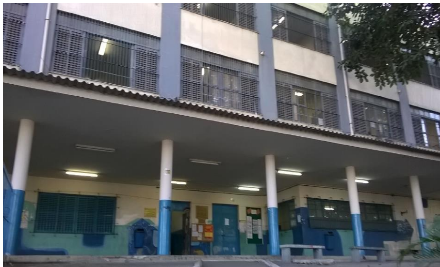
Foto 1 – Fachada do Colégio Estadual Prof. Clóvis Monteiro (CEPCM)
