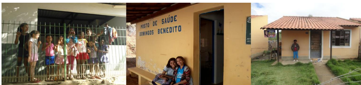
Figura 27: Creche Municipal e o Posto de Saúde, revitalizados após o projeto das casas populares do Distrito de Areias, Miracema, Rio de Janeiro/Brasil.
