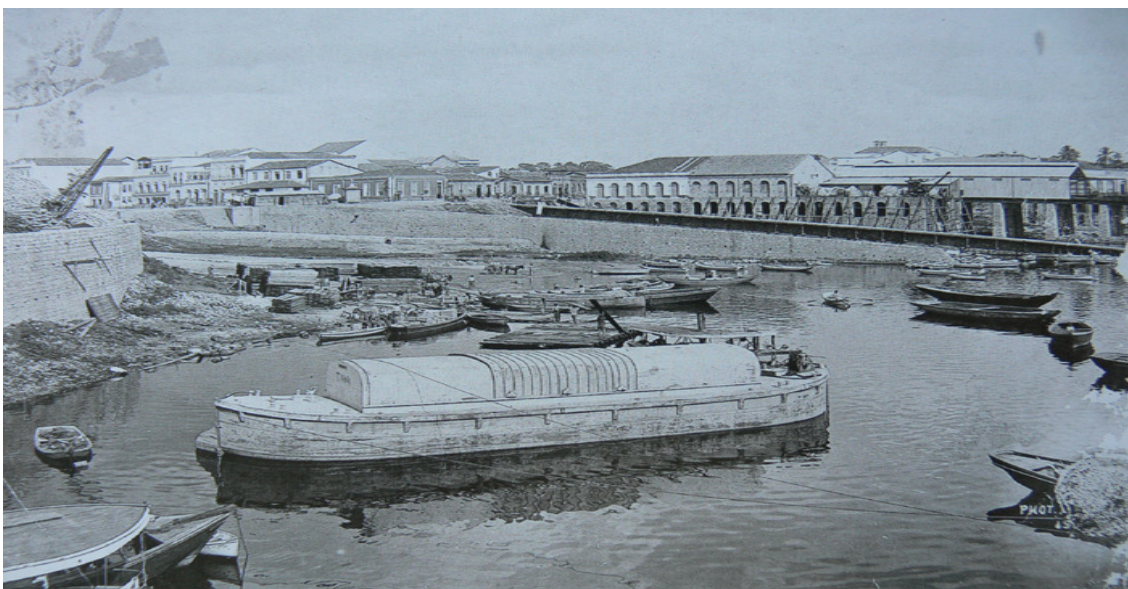
Figura 2: Obras do Porto de Manaus, 1901. Fonte: G. Huebner. In: Schoepf, 2005.
