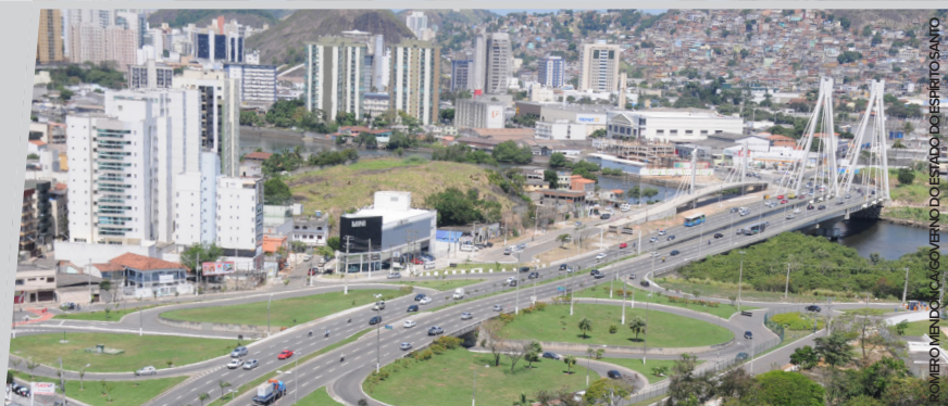
Obras de mobilidade e infraestrutura viária na Grande Vitória/ES.
