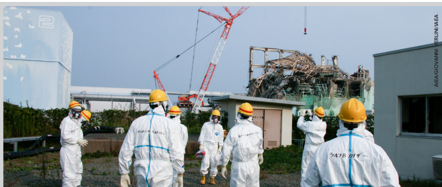
Visita ao Reator 3 na Usina Nuclear Daiichi em Fukushima/Japão pelo inspetores da ONU.
