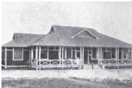
Hospital de Kalihi. Tipo de residência para dez hansenianos. Foto obtida por Souza Araújo quando visitou o Havaí na década de 1920 (1929, figura 25).
