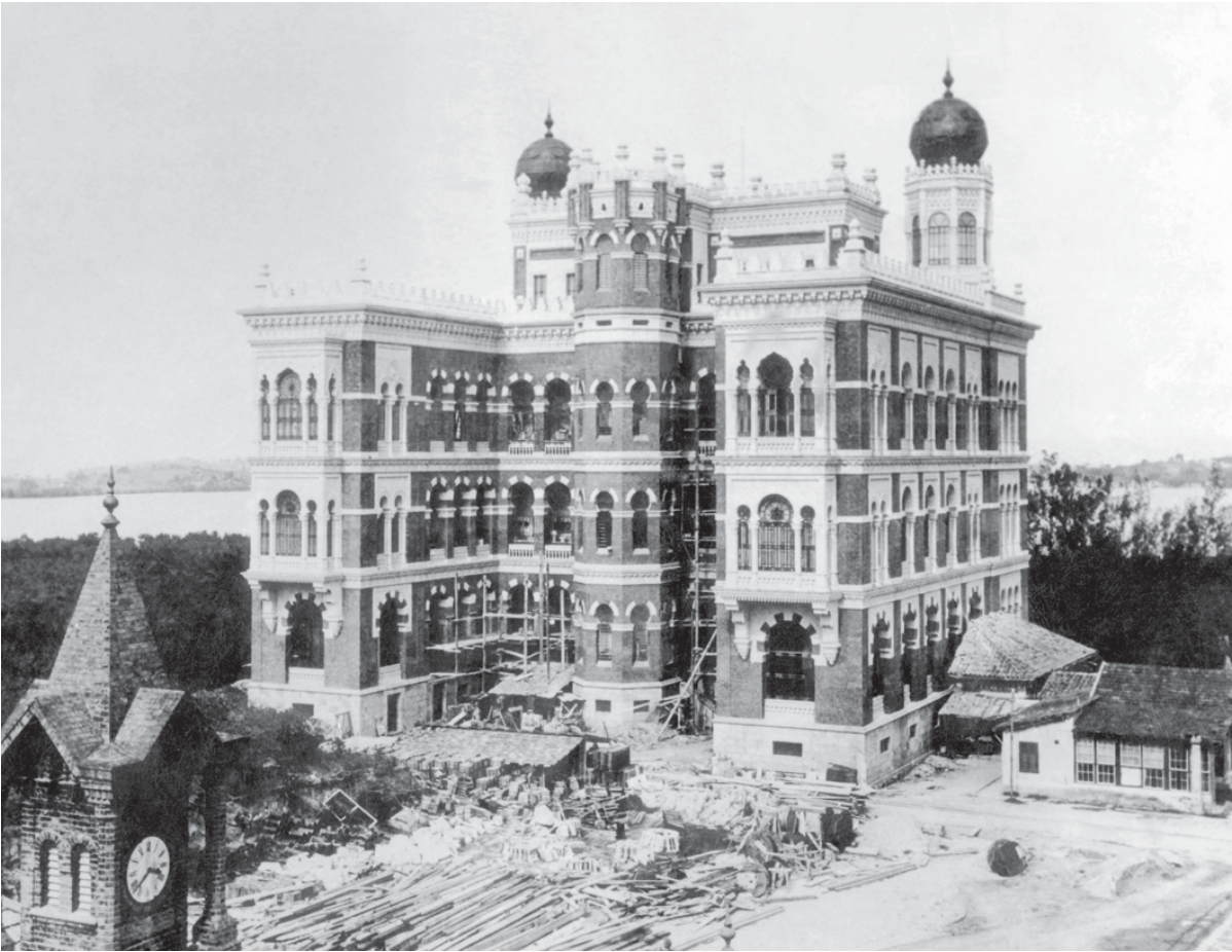
Novos edifícios em construção em 1908, à época em que Adolpho Lutz se transferiu para o Instituto Soroterápico Federal que, em março daquele ano, passou a se chamar Instituto Oswaldo Cruz (DAD/COC/Fiocruz).
