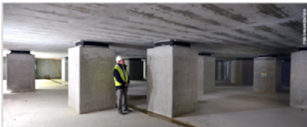
Alicerces com suspensão para absorver o impacto gerado por terremotos.
