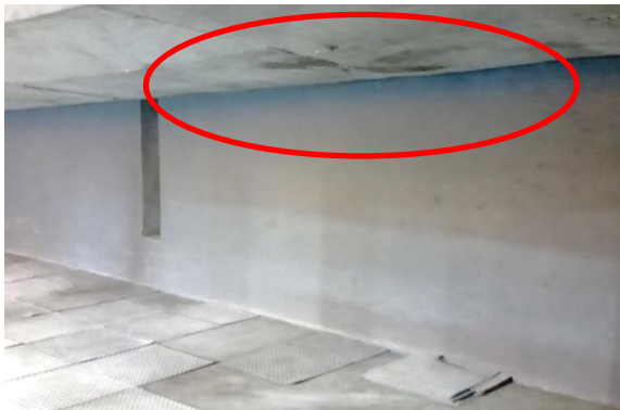
Parede face externa - marcas de umidade ocasionadas pelo acúmulo de água
