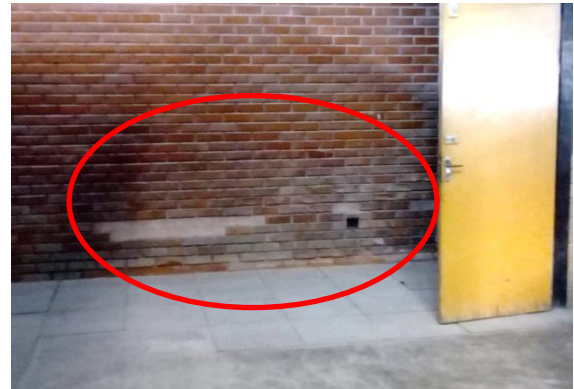
Subsolo – marcas de umidade
