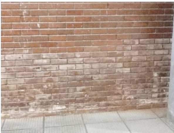
Fig. 16 – Marcas de umidade na parede do subsolo da biblioteca
