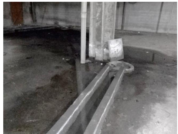
Fig. 16 – Marcas de umidade na parede do subsolo da biblioteca
