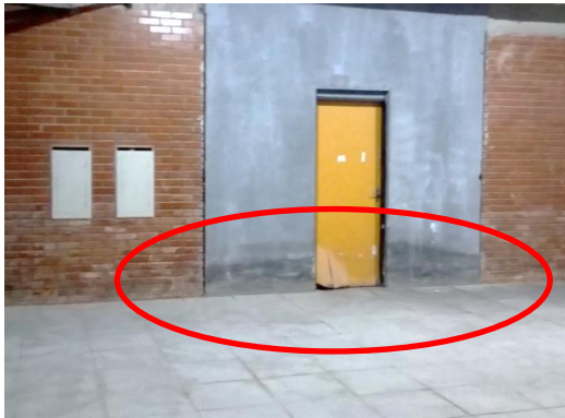
Subsolo – marcas de umidade
