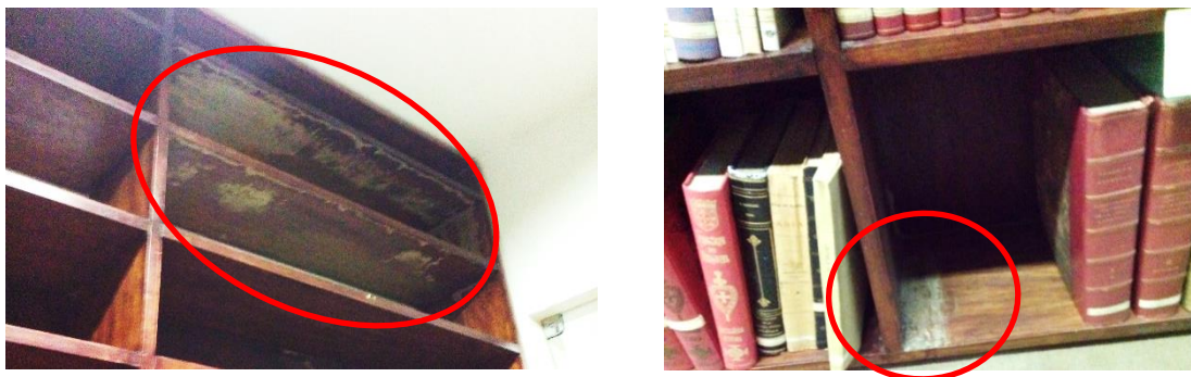
Fig. 26 – Marcas de ataque de cupim no mobiliário de madeira
