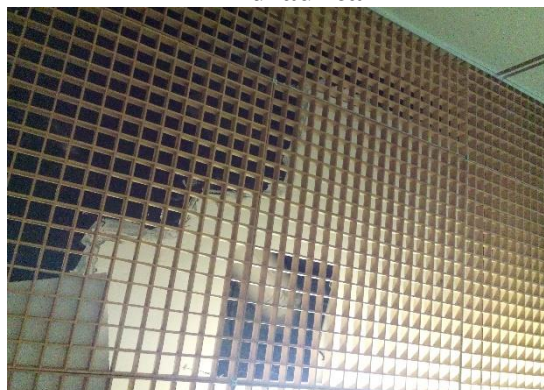
Forro de gesso danificado – tubulação hidráulica
