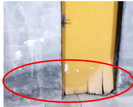
Parede face interna - acúmulo de água permanente
