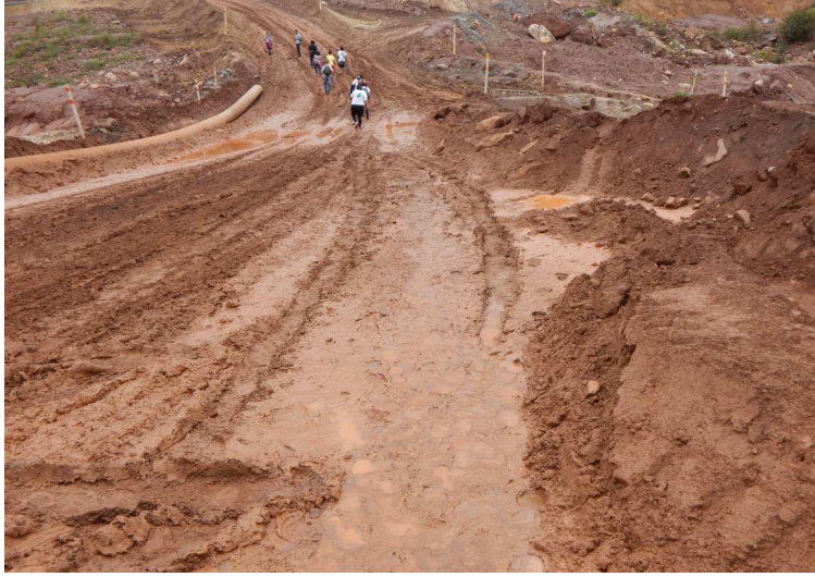
Figura 4 - Bento Rodrigues atingido pela lama.
