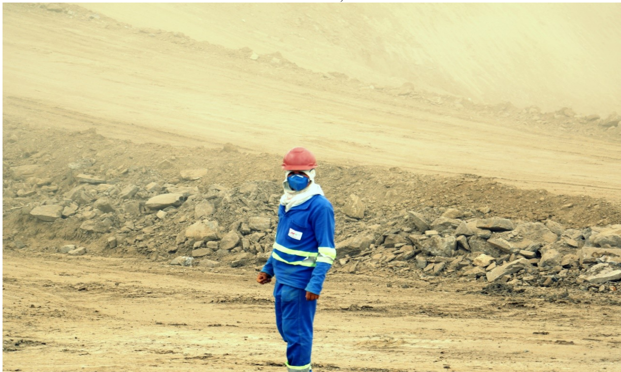
FIGURA 11 - Trabalhador da construção civil exposto a alta densidade de poeira nas obras da Transposição do rio São Francisco, 2014.
