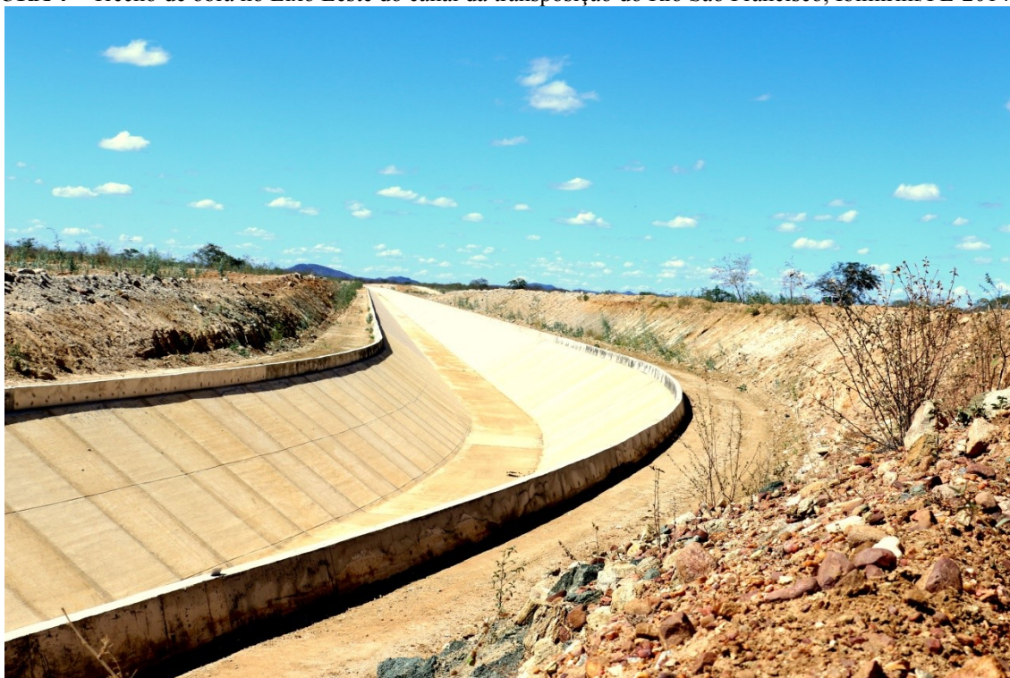
FIGURA 4 – Trecho de obra no Eixo Leste do canal da transposição do Rio São Francisco, Ibimirim/PE-2014
