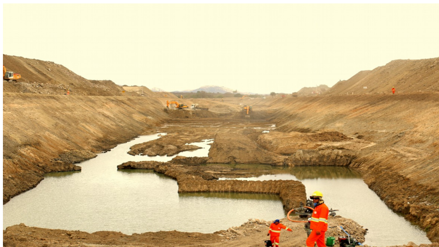
FIGURA 5 – Obras no Eixo Leste da Transposição do rio São Francisco, Sertânia/PE-2014
