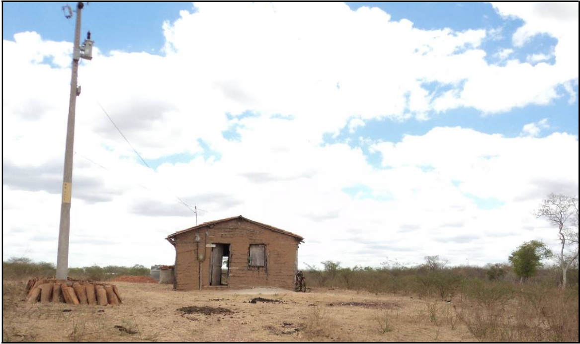
Figura 16 - Residência com fonte de energia elétrica (Fonte: Acervo pessoal).
