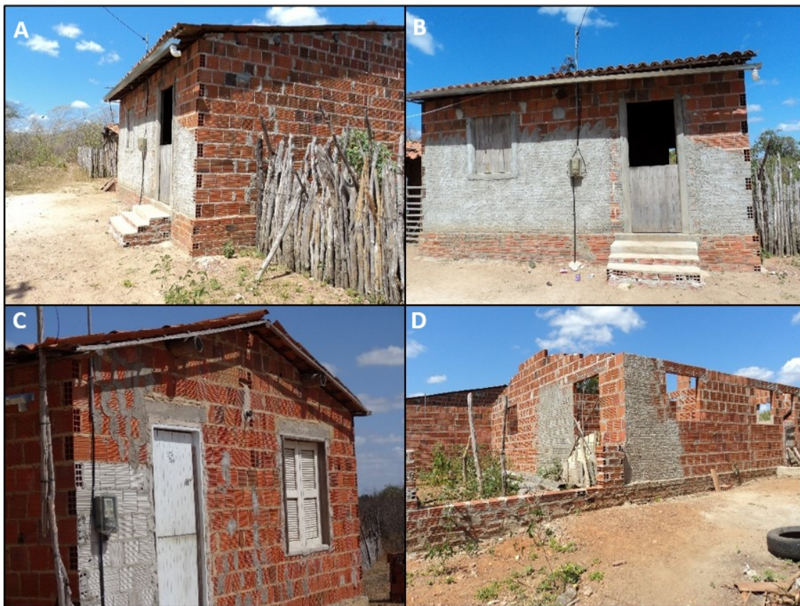
Figura 56 – A), B) e C) – Casas de alvenaria presentes nas cinco localidades rurais de Russas/Ce; C) Casa de alvenaria em processo de construção sem apresentar nenhum elemento estrutural.
