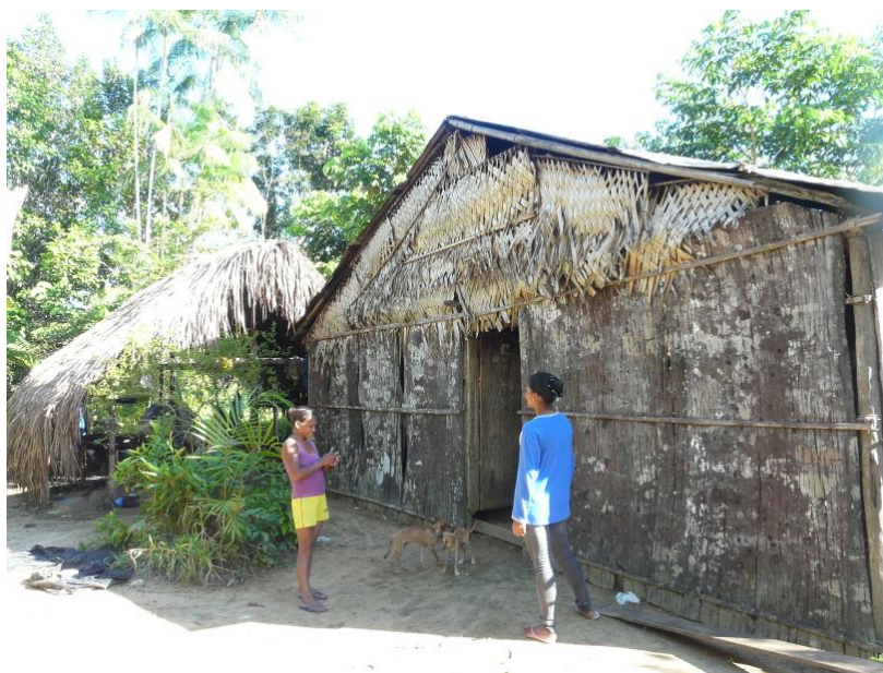
Figura 17- Típica casa Kotiria. Paredes de casca de árvore, telhado de zinco, chão de terra e cozinha separada em anexo (à esquerda).
