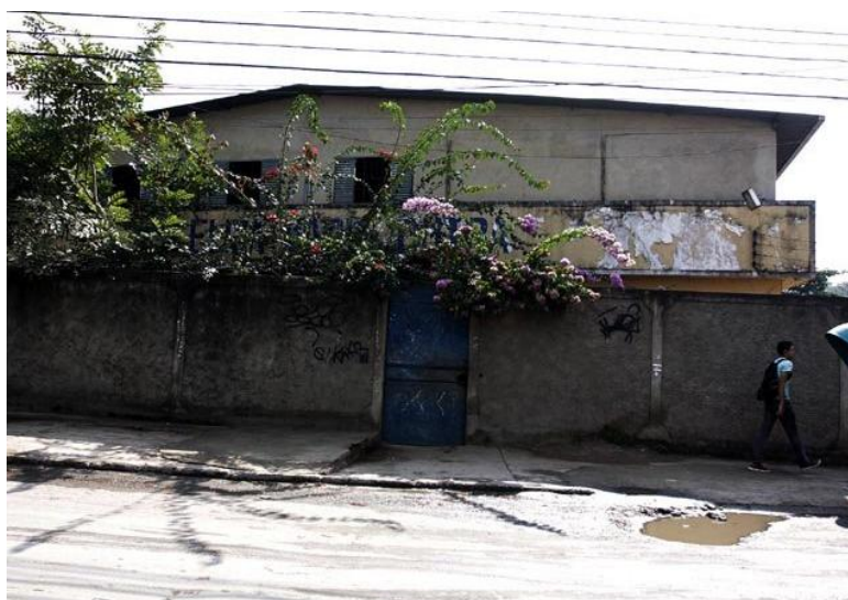
Figura 5.10 - Fotografia da fachada da Escola D Fonte: Foto da Autora
