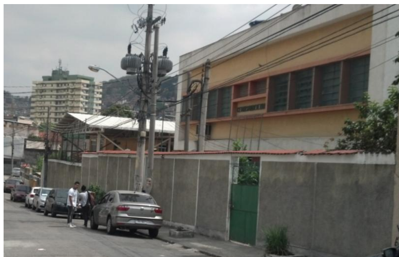
Figura 5.7 - Fotografia da fachada da Escola C Fonte: Foto da Autora
