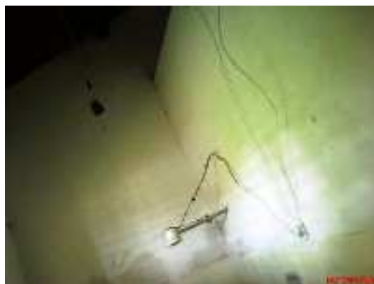
Figura 3 - Banheiros com ferrugem, vazamentos e fiação exposta.
