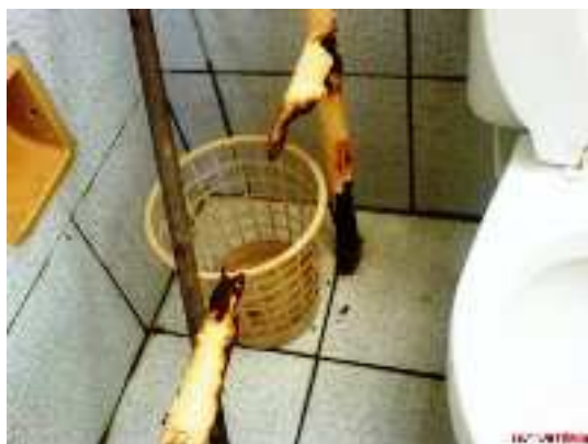
Figura 3 - Banheiros com ferrugem, vazamentos e fiação exposta.
