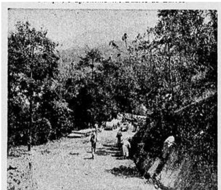
O ATUAL diretor do Serviço Florestal, agrônomo João Augusto Falcão, tem-se empenhado em completar as instalações do Parque Nacional de Itatiaia, assegurando aos visitantes o máximo de conforto. Aqui se vê o início de construção de uma das excelentes estradas que servem ao Parque, com oito metros de largura e apenas 4% de rampa. Ao fundo, aparece o edifício principal do Parque, de linhas grandiosas.
